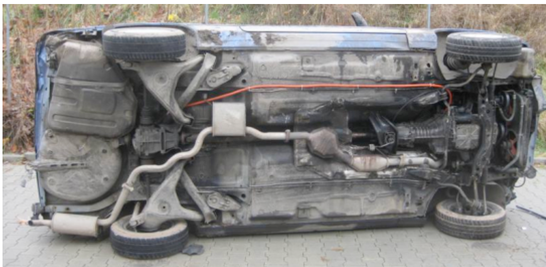
Abbildung 39: Nachträglich angebrachtes Hochvoltkabel am Fahrzeugboden
